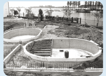
4 Het opvangcentrum in aanbouw in 1990.
